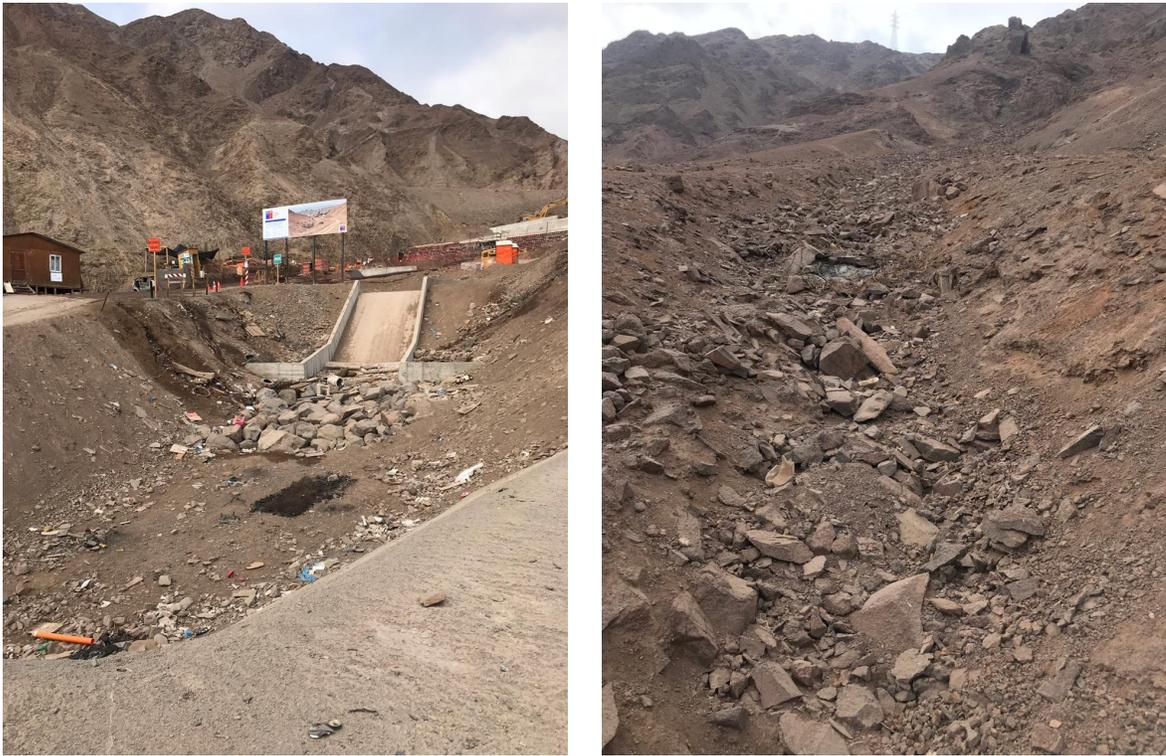
**Figura 11. Villa Constancia Nueva 2. (a)** Construcción de piscinas decantadoras para mitigar aluviones. **(b)** Imagen de quebrada cercana a Villa Constancia Nueva 2, donde se observan clastos de diferentes granulometrías, así como también las laderas con materia no consolidado. Estas quebradas deben ser tratadas por el gobierno local y autoridades competentes para reducir riesgos de desastres que pueden afectar a toda la ciudad.
